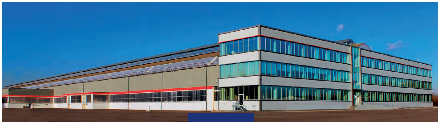
Vista del Camozzi Research Center di Milano.
